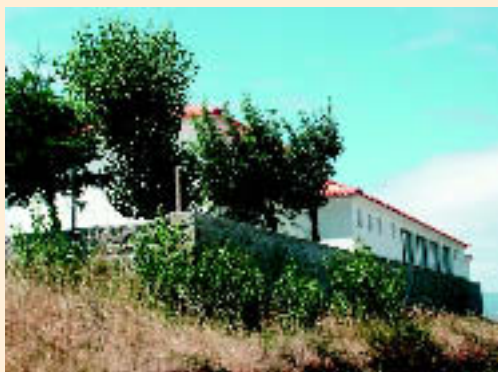
Ośrodek rekreacyjny w Gandrze mieści się w szkole podstawowej – elewacja prawej strony budynku i ściany tylnej (faza przed realizacją projektu)
