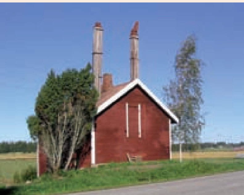
Harmonia barw przywrócona przydrożnym budynkom
