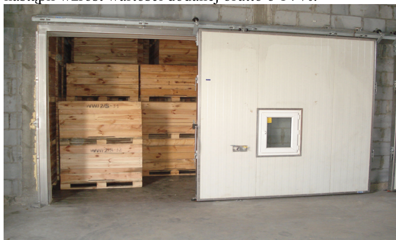
Fot. Rozbudowa przechowalni owoców
